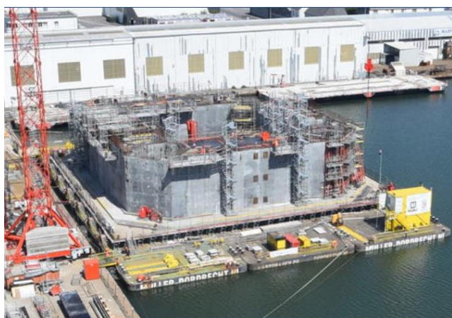
写真1 Floatgen の建設現場 (写真は4月19日現在)
